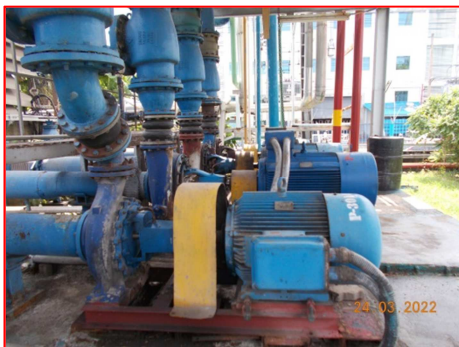
ภาพที่ 2.2-28 อุปกรณ์ครอบเครื่องจักร ที่มีการหมุน
