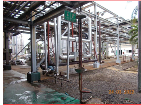
ภาพที่ 2.2-22 อ่างล้างตาและฝักบัวฉุกเฉิน
