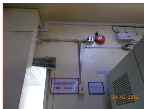
ภาพที่ 2.2-45 สัญญาณเสียงเตือนเหตุ เพลิงไหม้ (Fire Alarm)
