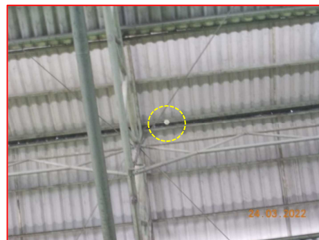
ภาพที่ 2.2-37 ระบบตรวจจับควัน (Smoke Detector) บริเวณพื้นที่ Ware House
