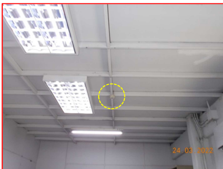
ภาพที่ 2.2-38 ระบบตรวจจับความร้อน (Heat Detector) บริเวณพื้นที่ Store
